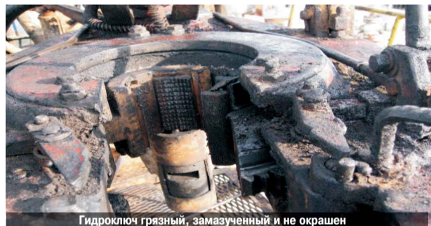
Гидроключ грязный, замазученный и не окрашен
